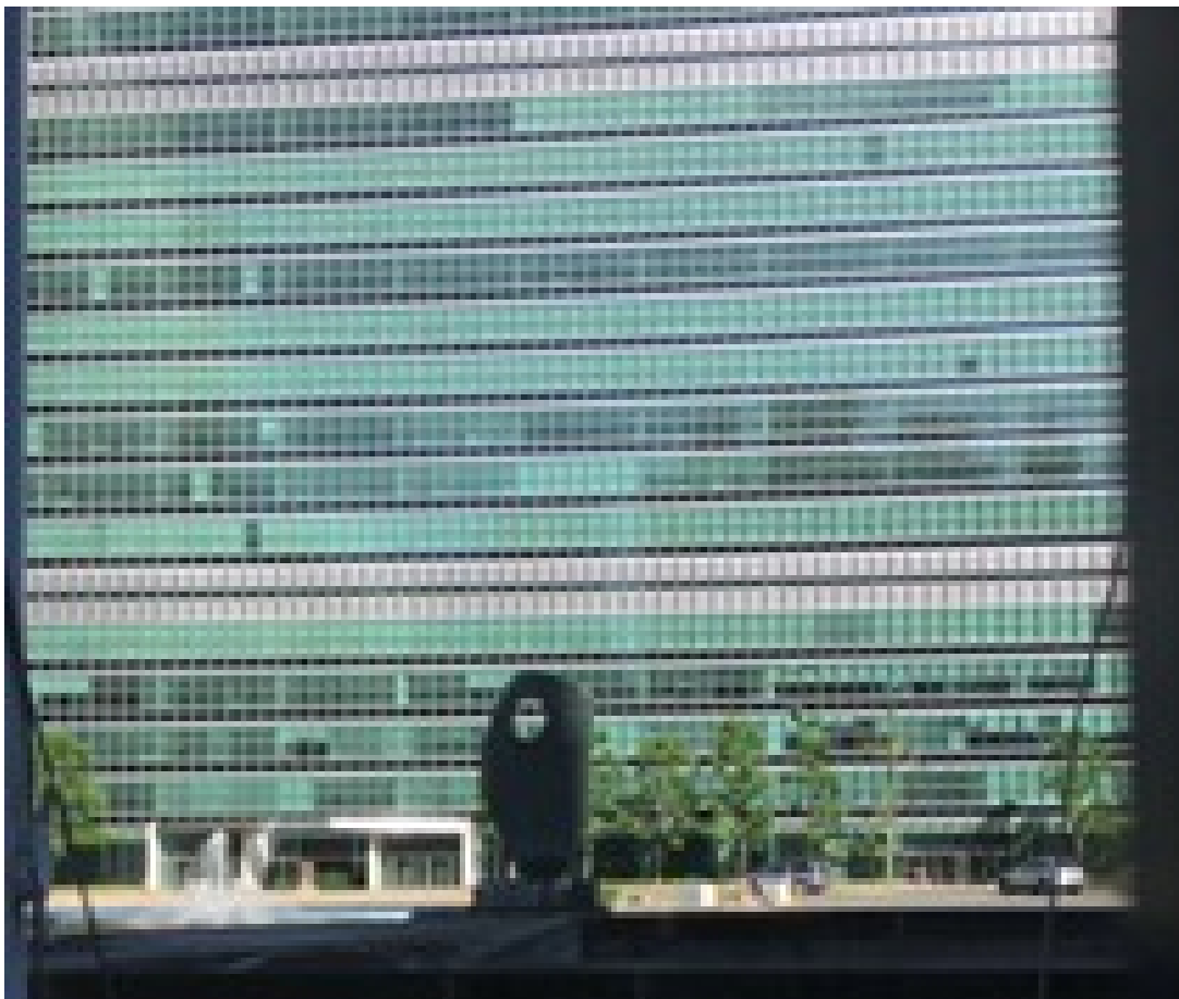
Edificio de las Naciones Unidas. Detalle
