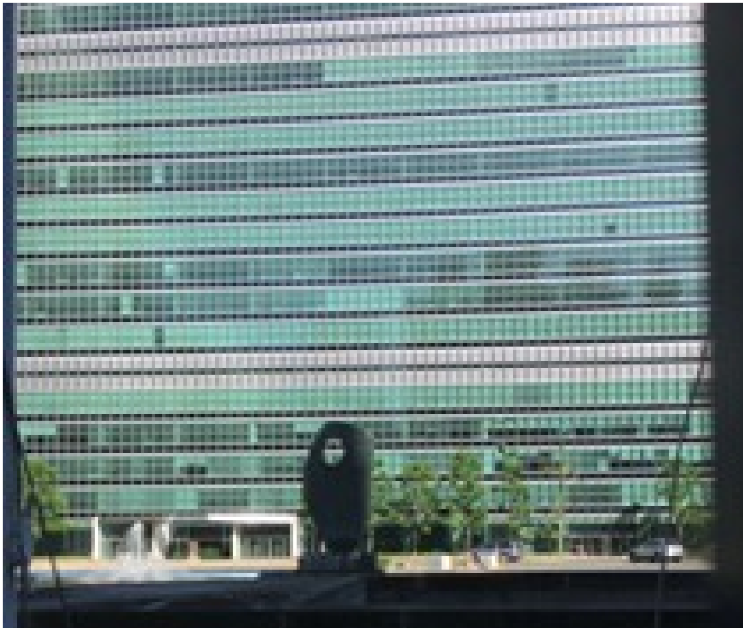
Edificio de las Naciones Unidas. Detalle
